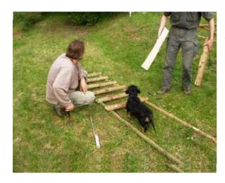
Nun wird die Leiter gefertigt, als Sprossen werden die unteren dicken Enden der Stangen genommen, sie werden mit der Motorsäge halbiert.
