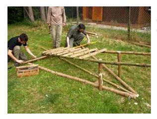
Nun wird die Leiter unten mittig an das Querholz angenagelt, dass die Leiterholme genau so lang sind wie die Streben.
